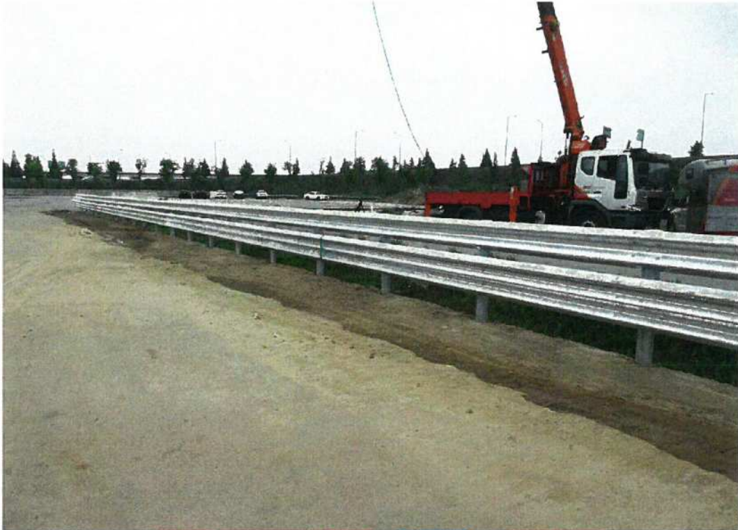
<대형차 시험 전 시설물 설치전경>
