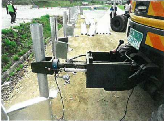
<지주 시험체 설치>
