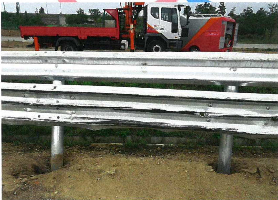
<대형차 시험 후 시설물 전면부>
