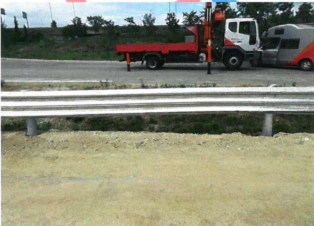
<소형차 시험 후 시설물 전면부>
