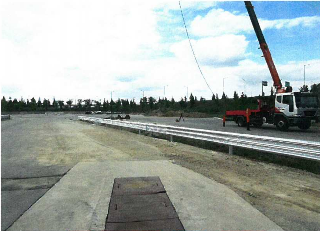
<소형차 시험 전 시설물 설치전경>
