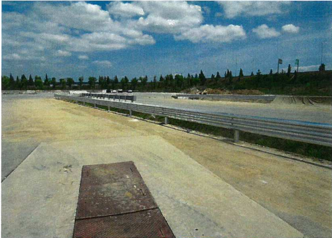
<대형차 시험 전 시설물 설치전경>
