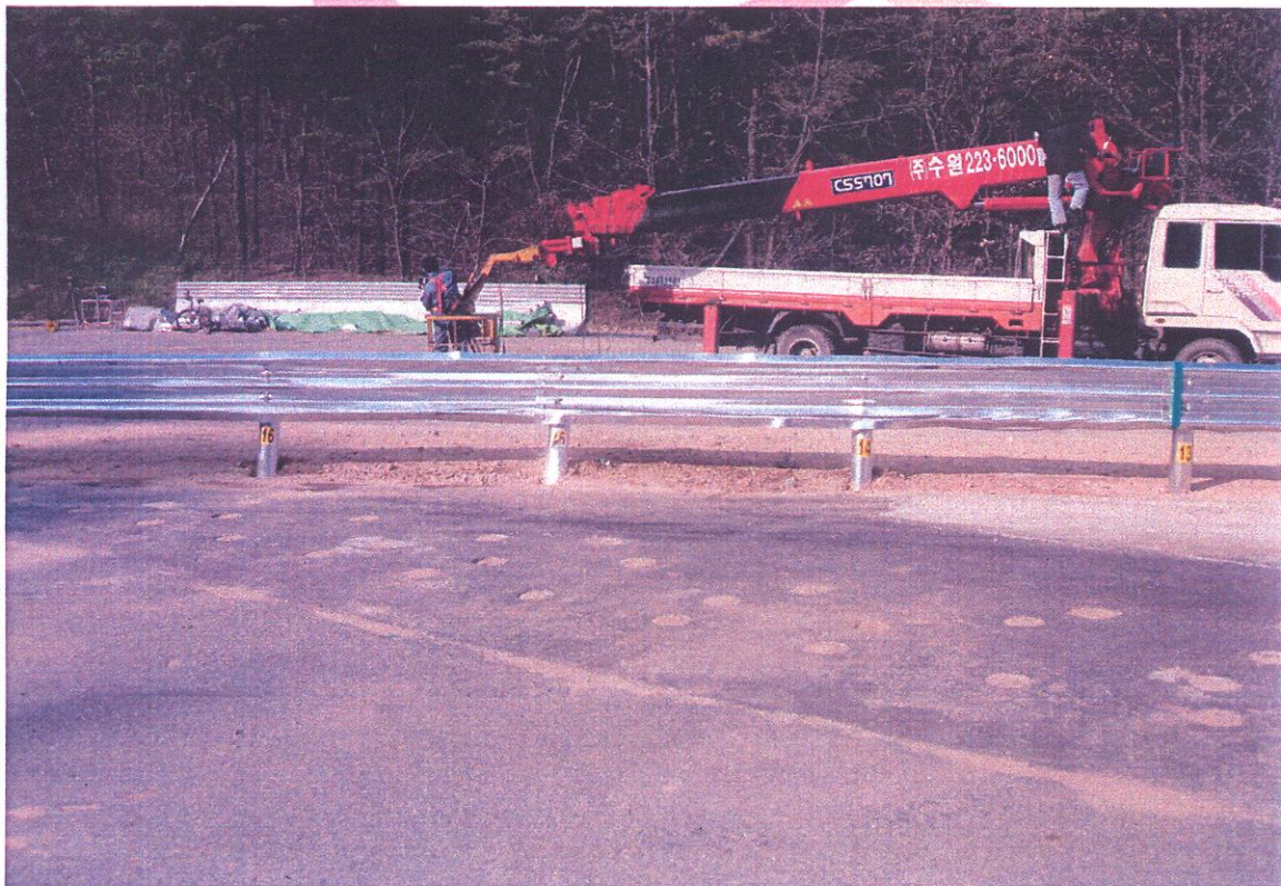
<대형차 시험 후 시설물 전면부>
