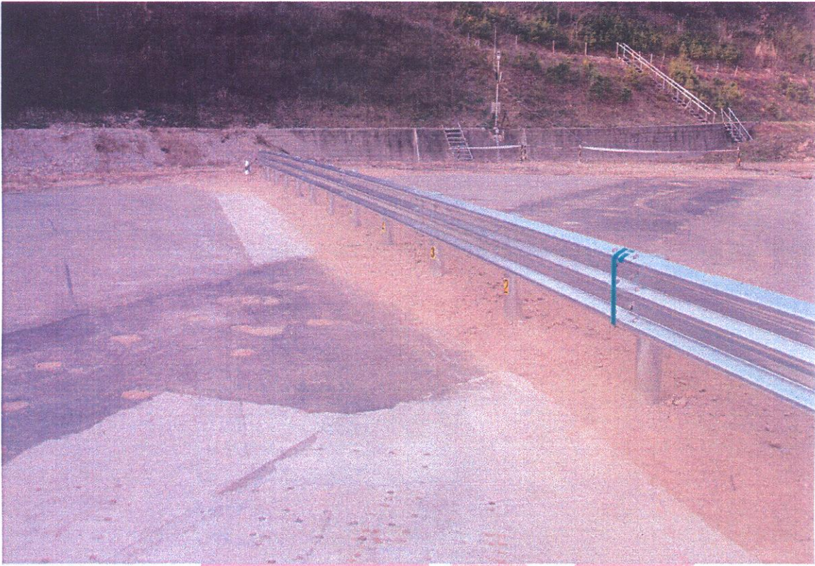
<소형차 시험 전 시설물 설치전경>
