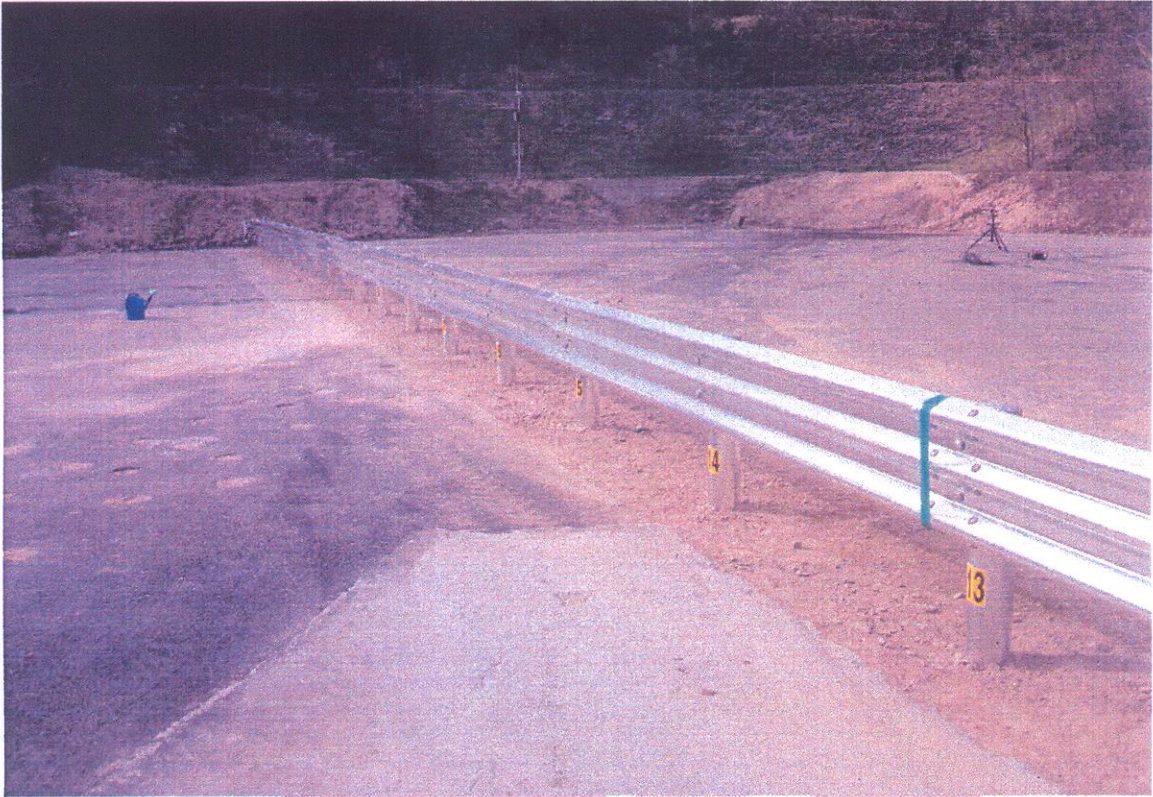
<대형차 시험 전 시설물 설치전경>
