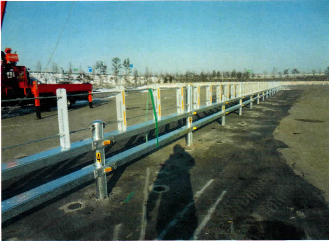
<대형차 시험 전 시설물 설치전경>
