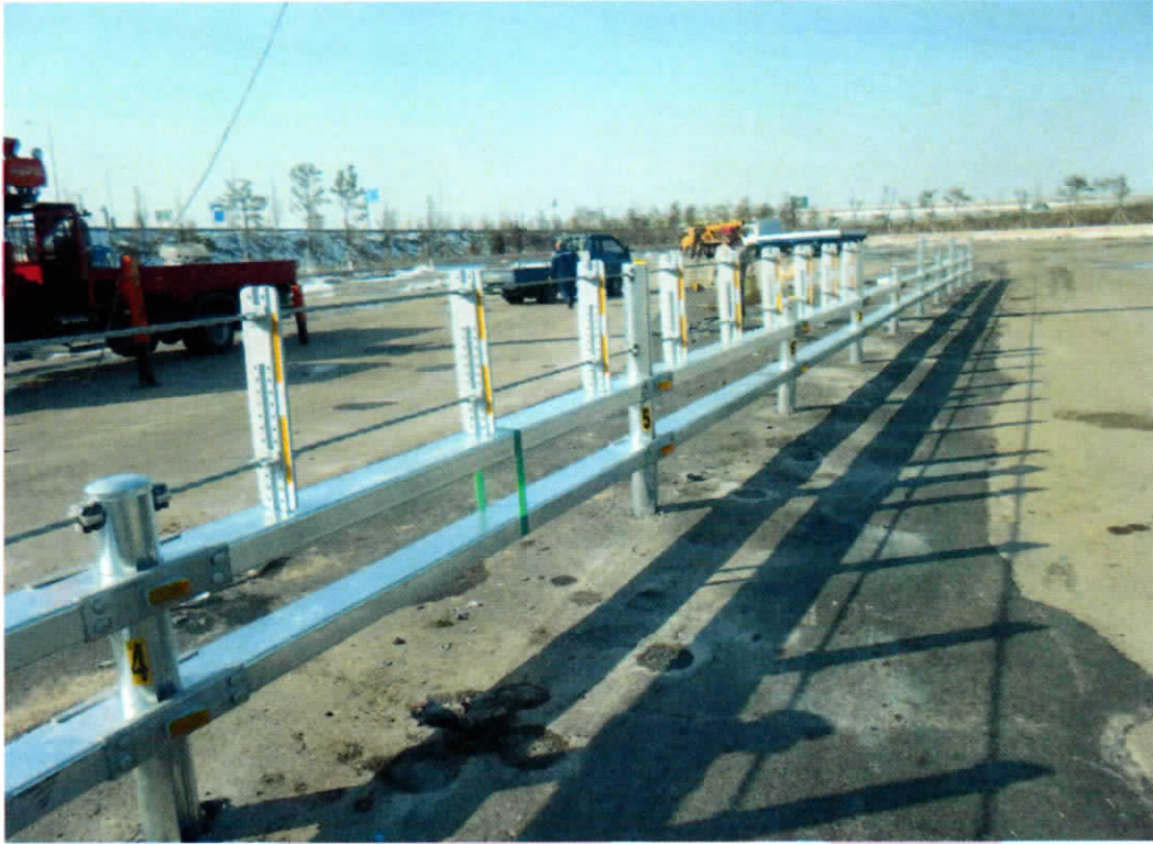
<소형차 시험 전 시설물 설치전경>
