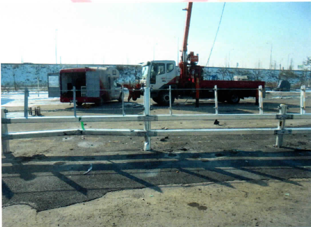
<소형차 시험 후 시설물 전면부>
