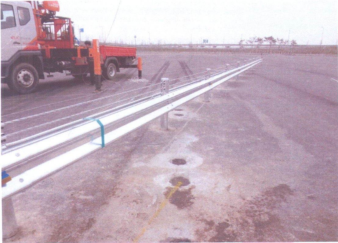
<소형차 시험 전 시설물 설치전경>
