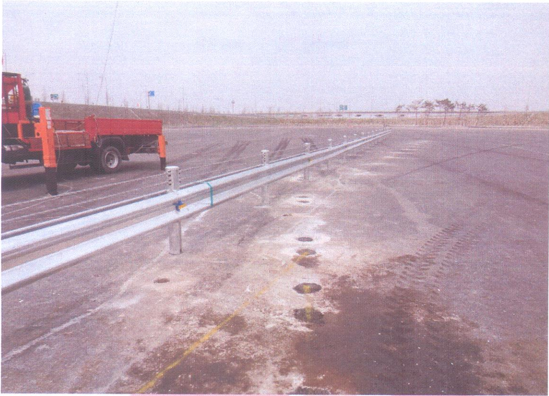
<대형차 시험 전 시설물 설치전경>
