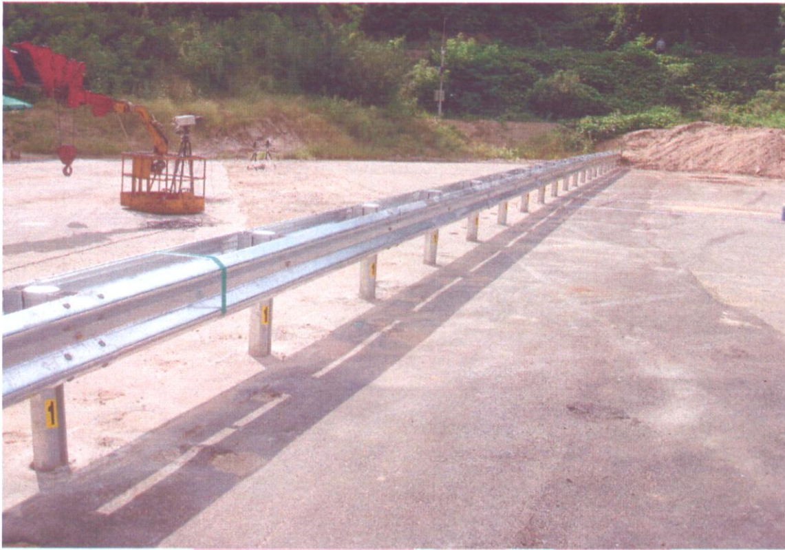
<대형차 시험 전 시설물 설치전경>
