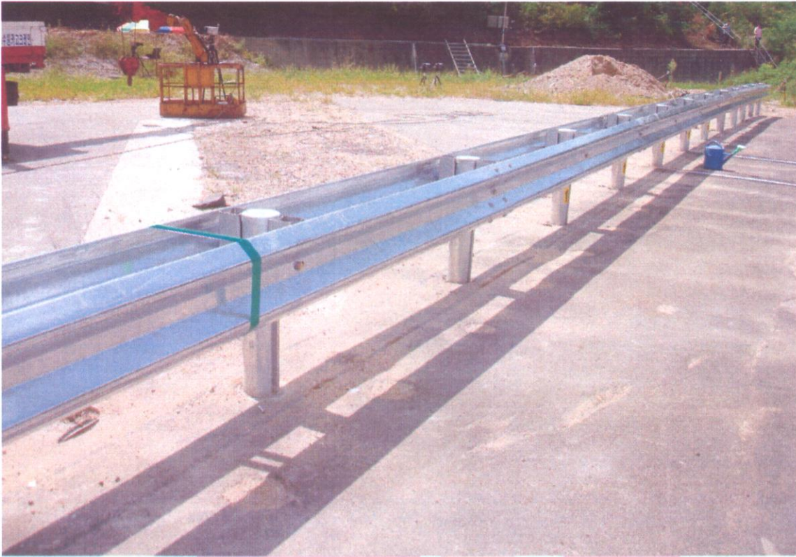
<소형차 시험 전 시설물 설치전경>
