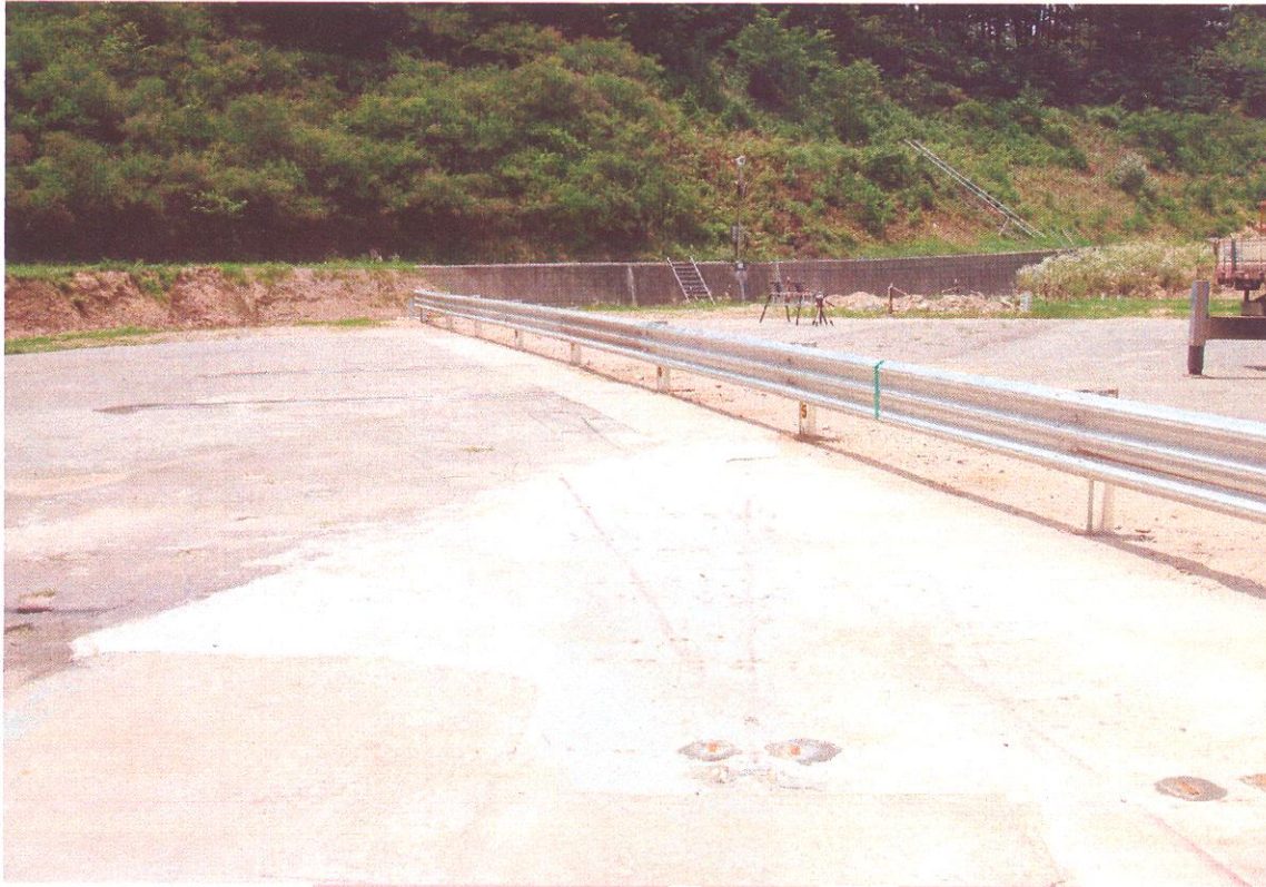
<소형차 시험 전 시설물 설치전경>
