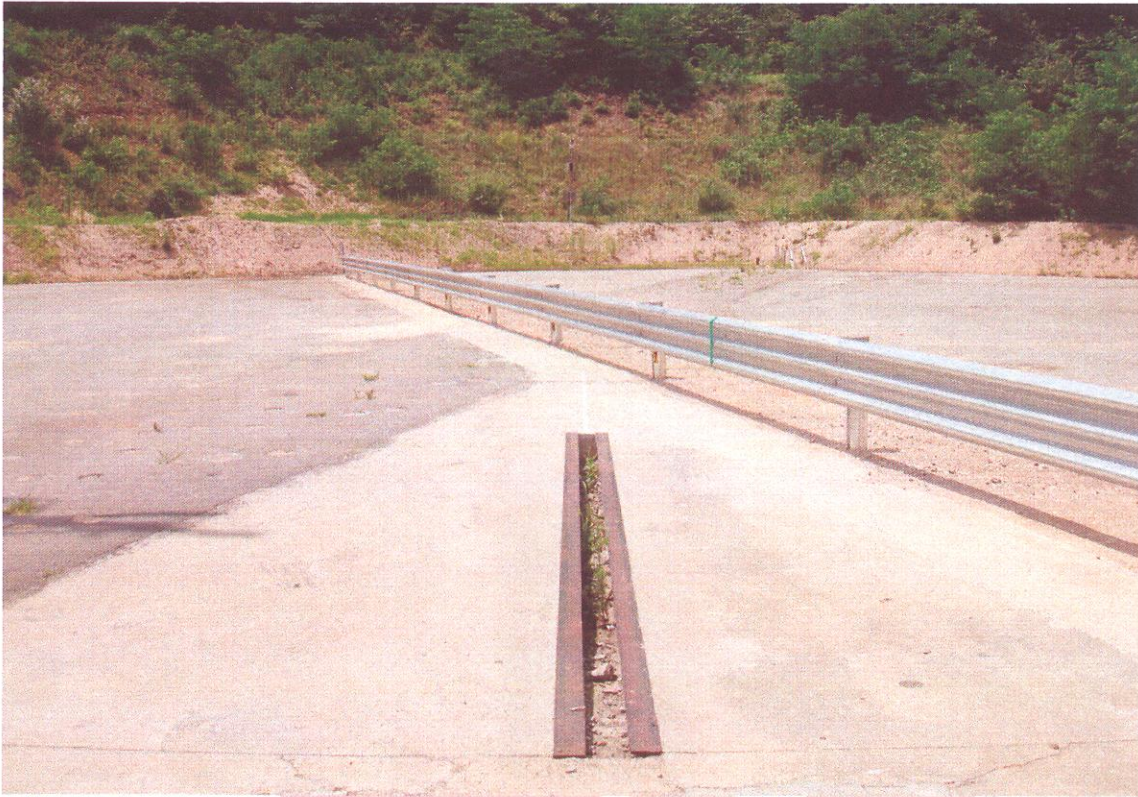
<대형차 시험 전 시설물 설치전경>
