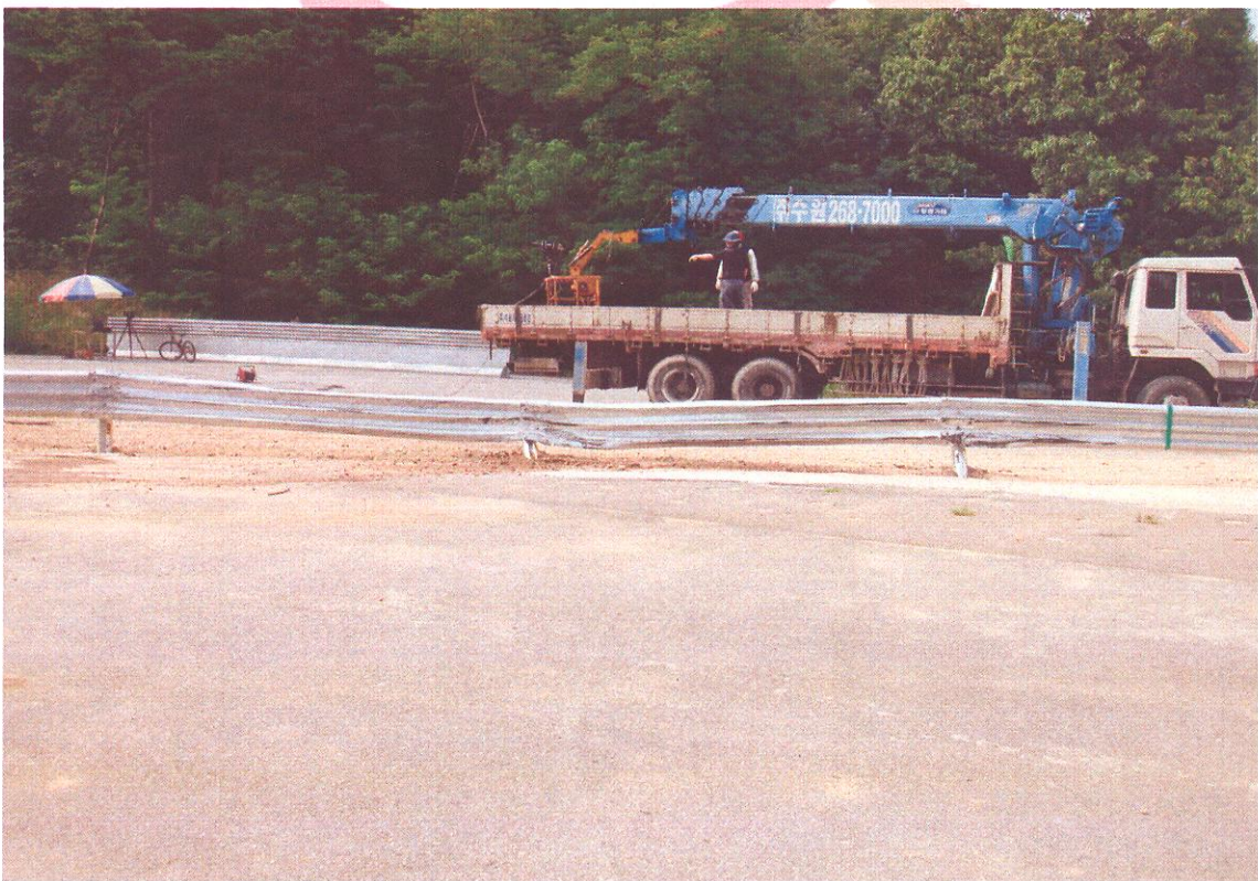
<대형차 시험 후 시설물 전면부>
