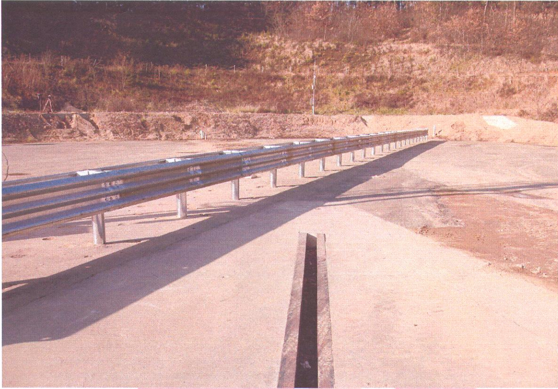
<대형차 시험 전 시설물 설치전경>
