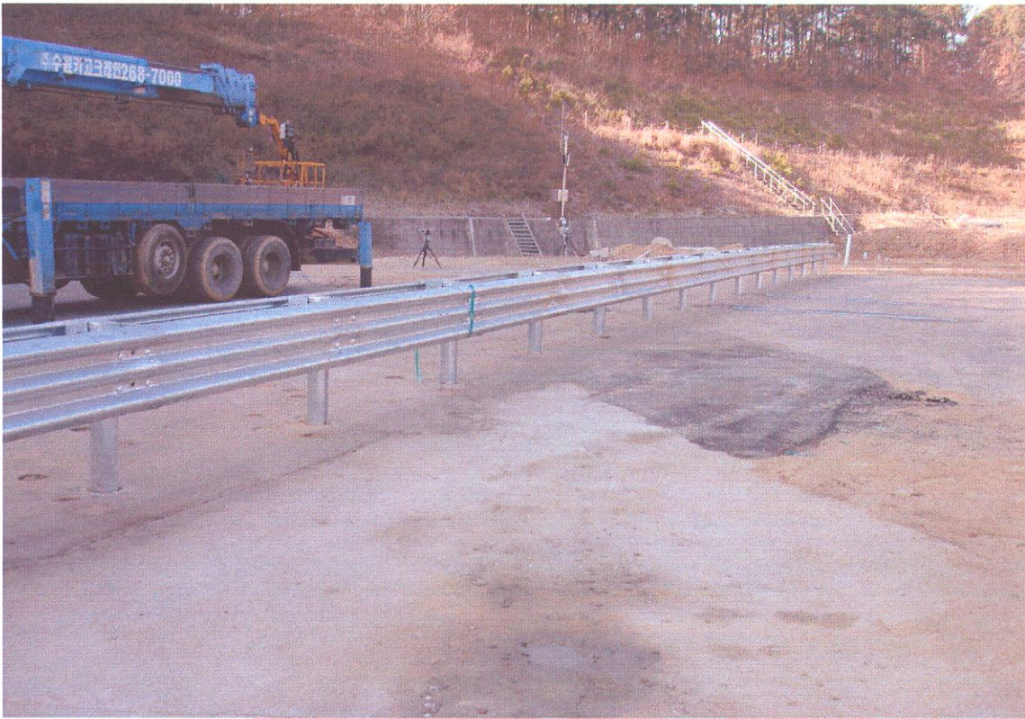
<소형차 시험 전 시설물 설치전경>
