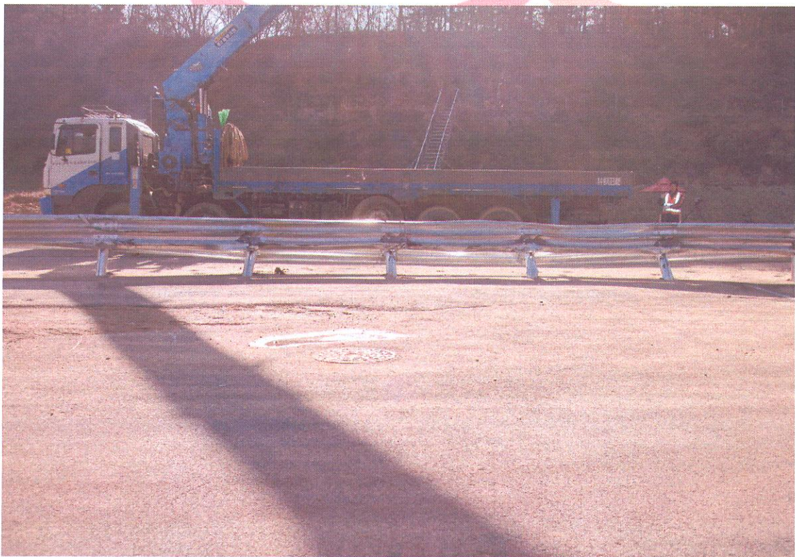
<대형차 시험 후 시설물 전면부>
