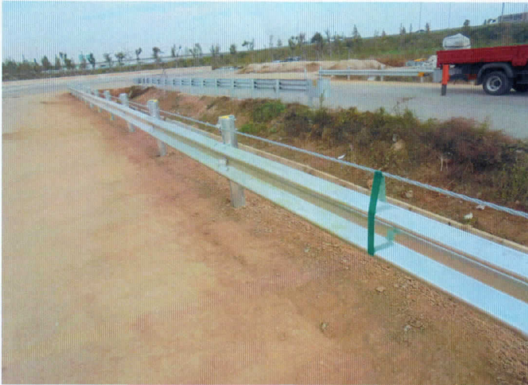
<대형차 시험 전 시설물 설치전경>
