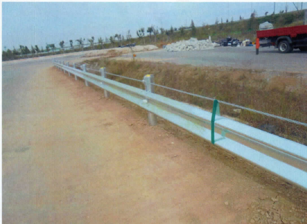
<소형차 시험 전 시설물 설치전경>
