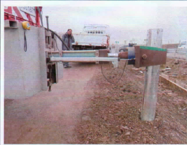
<지주 시험체 설치>
