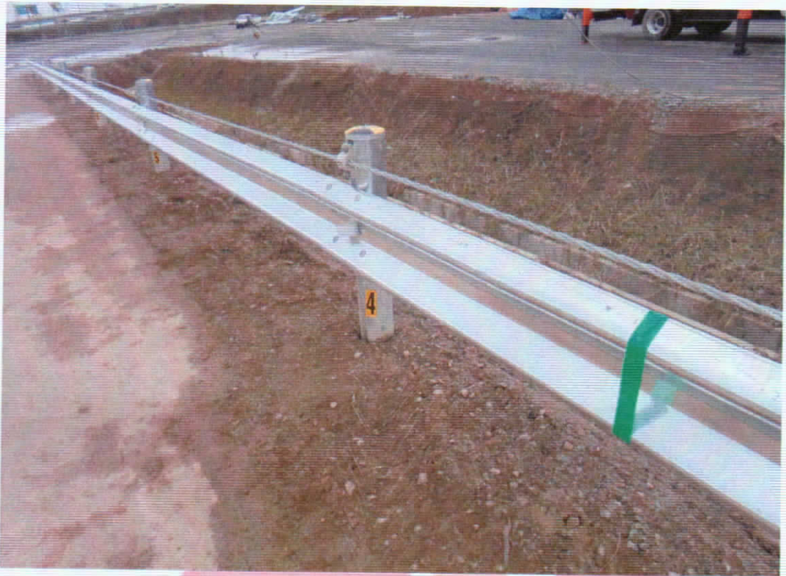
<소형차 시험 전 시설물 설치전경>
