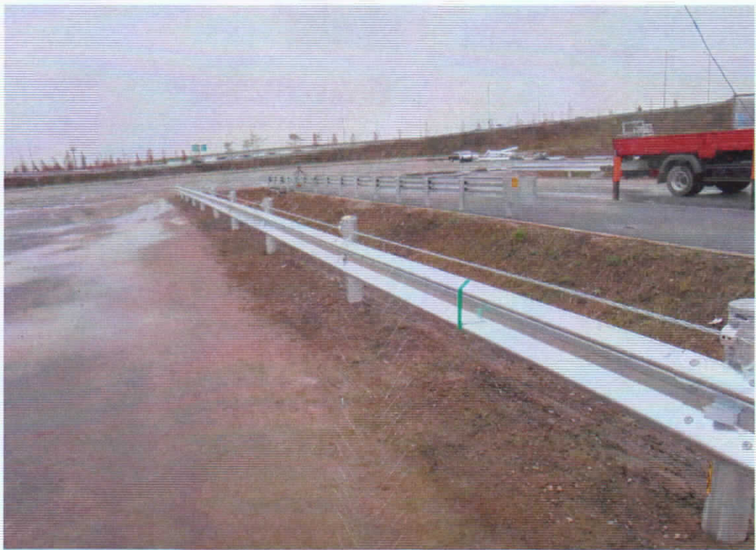
<대형차 시험 전 시설물 설치전경>
