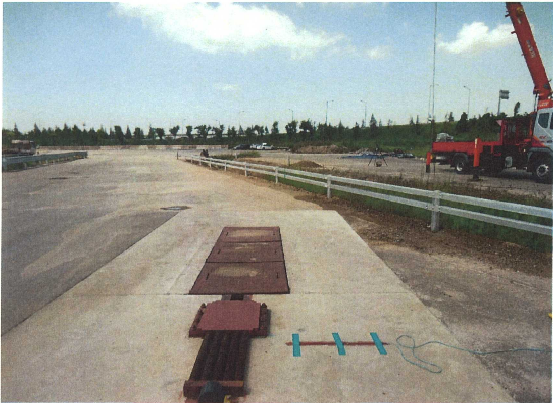
<소형차 시험 전 시설물 설치전경>
