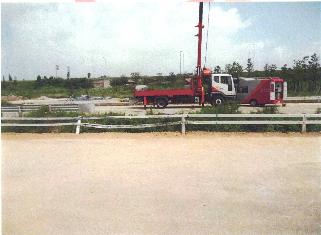
<대형차 시험 후 시설물 전면부>
