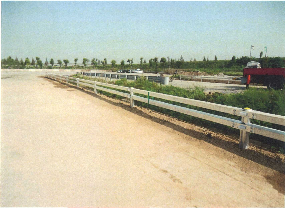
<대형차 시험 전 시설물 설치전경>
