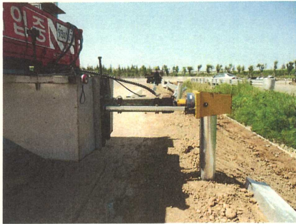
<지주 시험체 설치>
