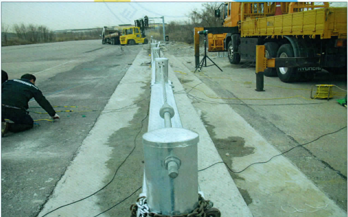
트럭시험 - 시험 후 충돌차량 궤적 및 시험물의 구성 부재 분리·비산 상황 사진
