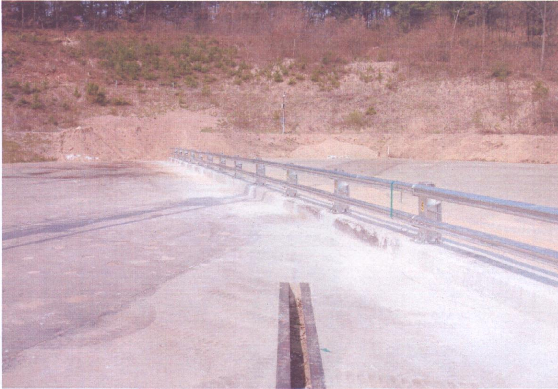
<대형차 시험 전 시설물 설치전경>
