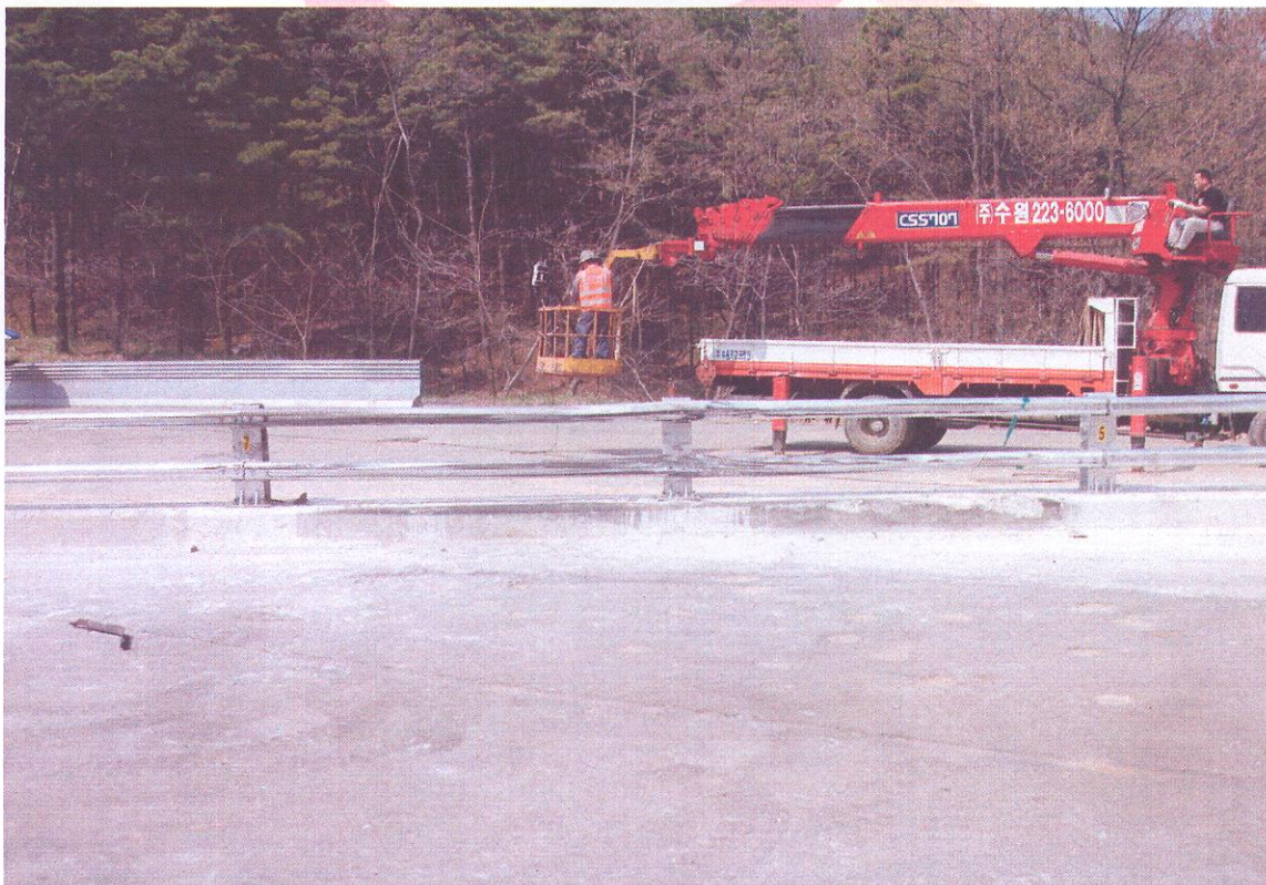
<대형차 시험 후 시설물 전면부>
