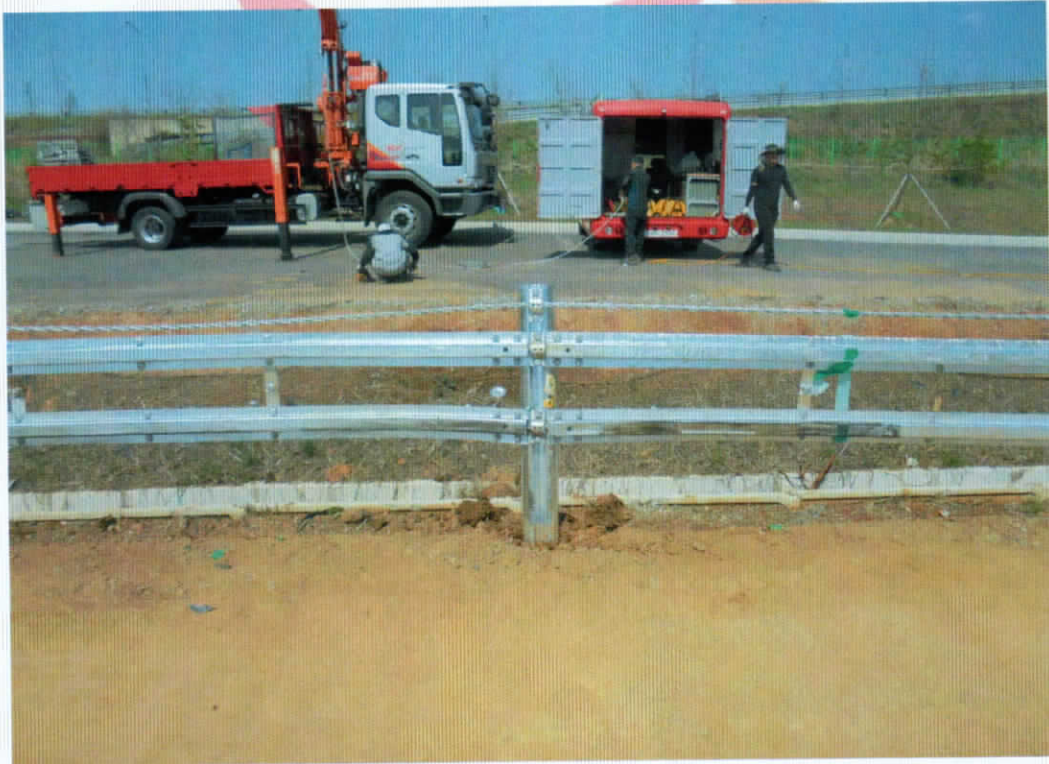
<소형차 시험 후 시설물 전면부>
