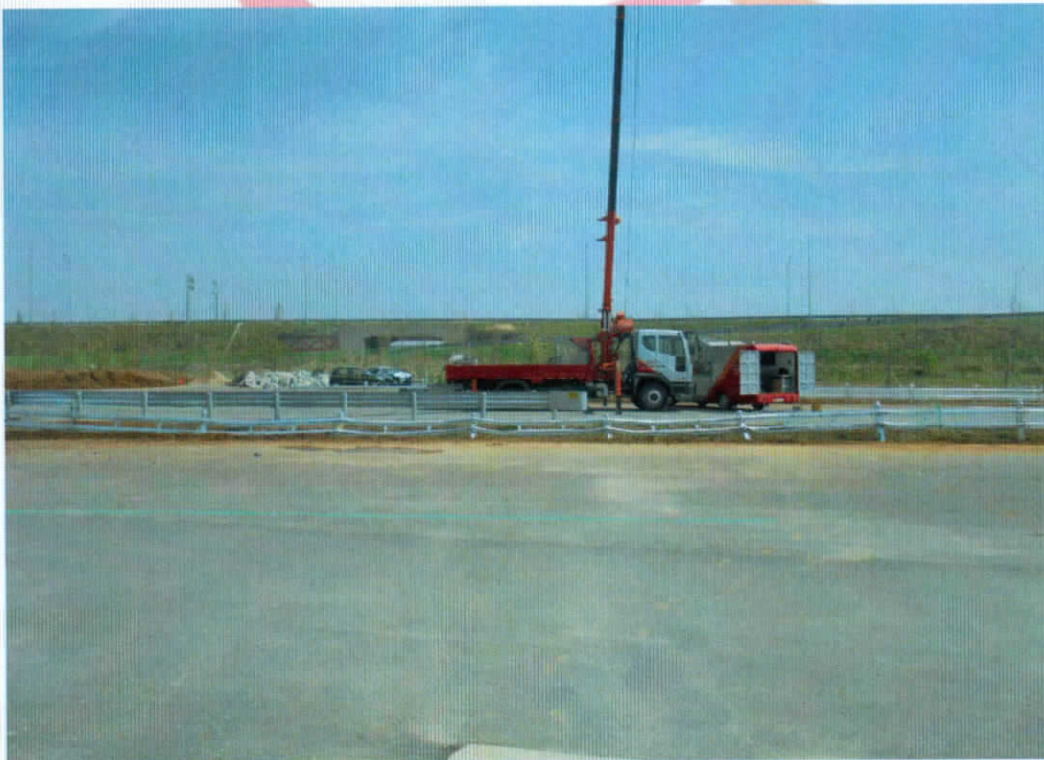
<대형차 시험 후 시설물 전면부>
