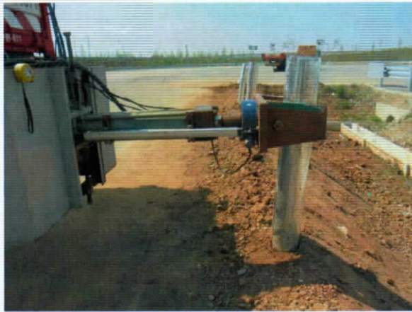
<지주 시험체 설치>
