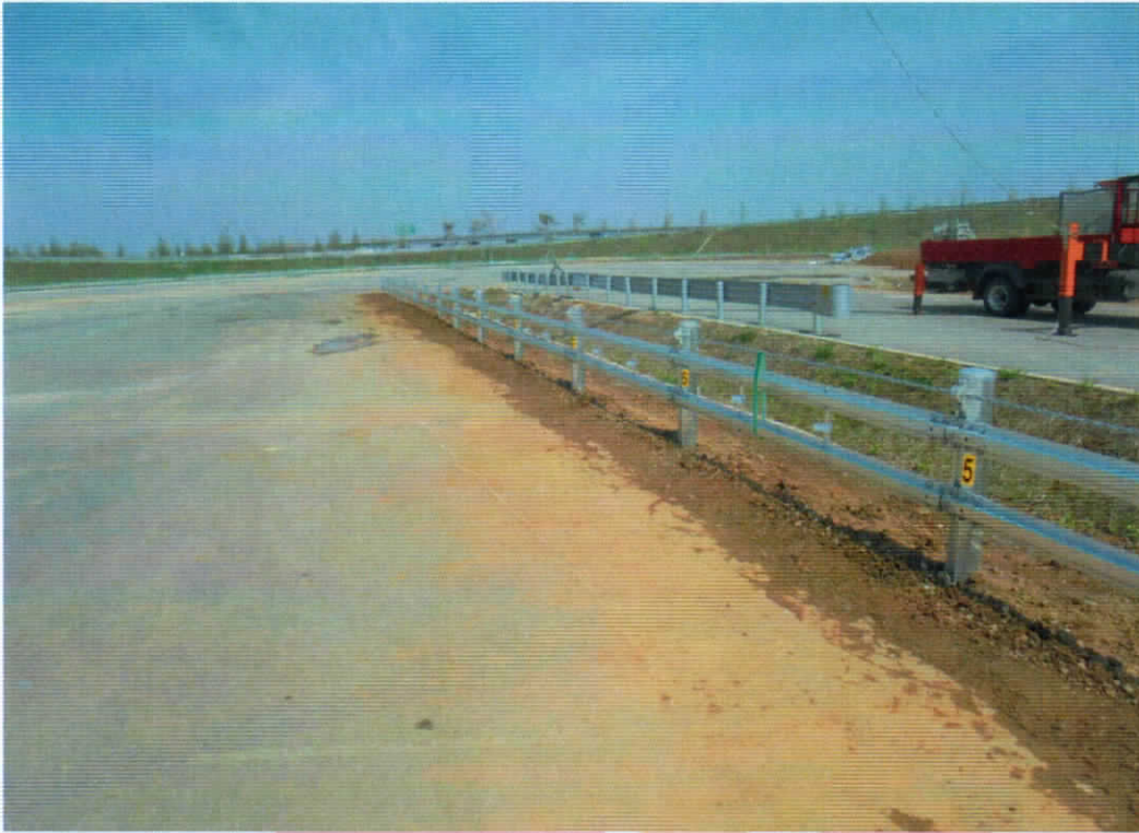
<대형차 시험 전 시설물 설치전경>
