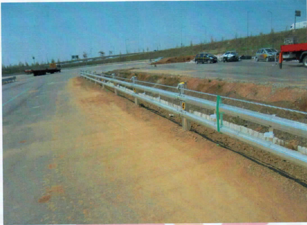
<소형차 시험 전 시설물 설치전경>
